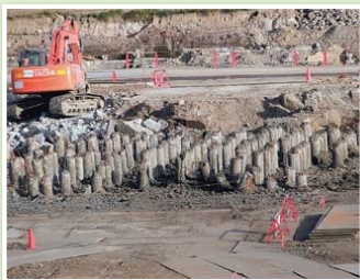
むき出しになったコンクリート杭の一部。東京カス工場建物の基礎杭が地中に1万8千本も埋まっていました。=2012年9月17日撮影
