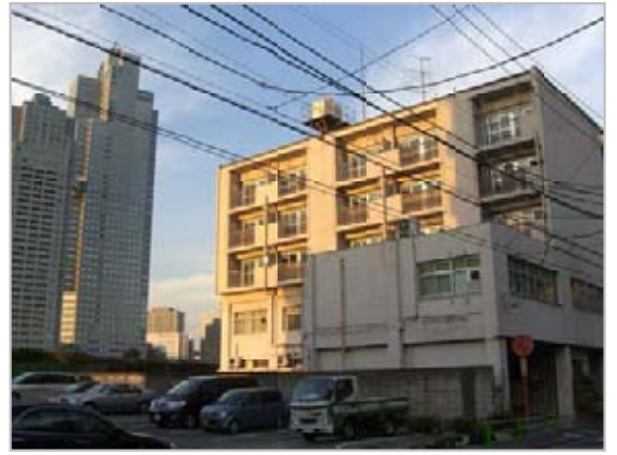
隅田川に隣接する旧区営月島三丁目アパート
