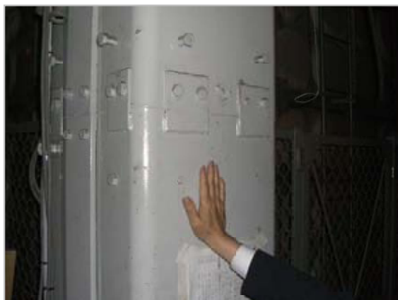
奈落の柱は、耐震補強がされていました
