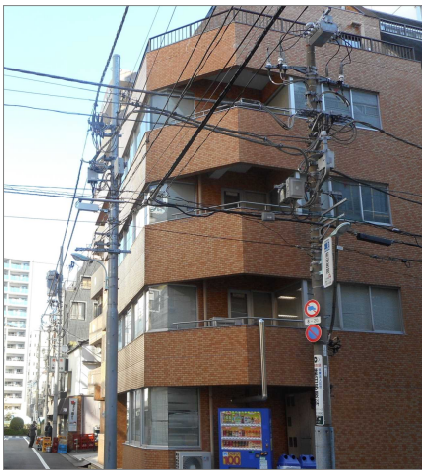
まちには電柱が林立しています
