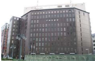
区役所本庁舎
